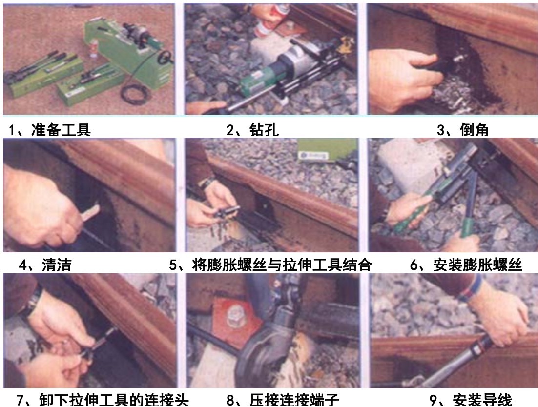
图 4-6 膨胀塞钉施工工序
